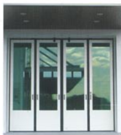
photo 上3 フォレスバ大子 茨城県久慈郡大子町 (完成: 1998年) ●手動式・ステンレス製 ●寸法: W7400×H4200 ●数量: 6セット
